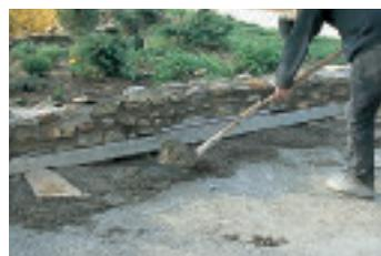
**4. Déposer le mortier de pose sous la règle.**
