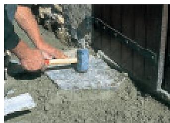
**6. Poser chaque dalle de pierre en l'enfonçant au maillet en caoutchouc dans le lit de mortier.**
